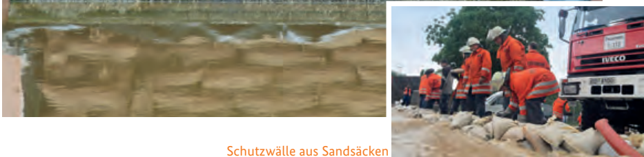
Schutzwälle aus Sandsäcken
